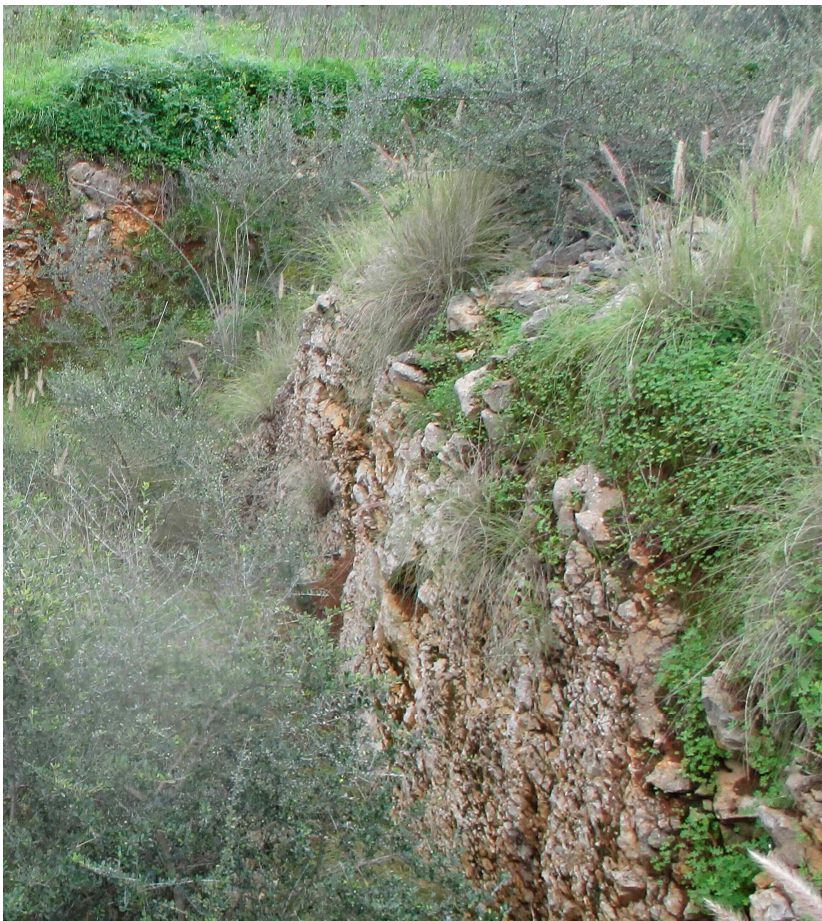
Fig. 4.1.: Particolare affioramento roccioso nei luoghi di interesse (Calcare).
